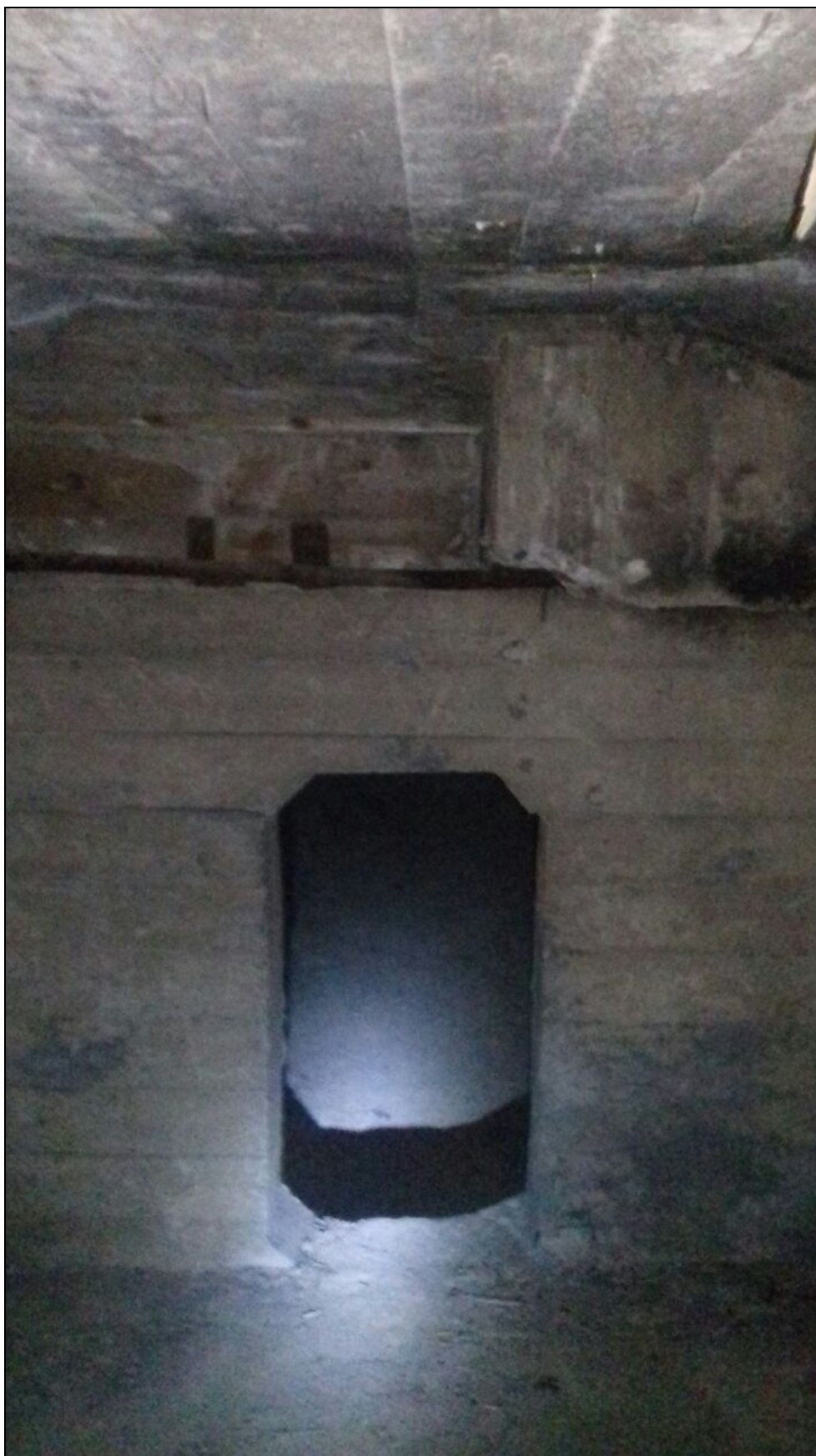
Рис. 27. Общий вид внутри балок пролетного строения.
