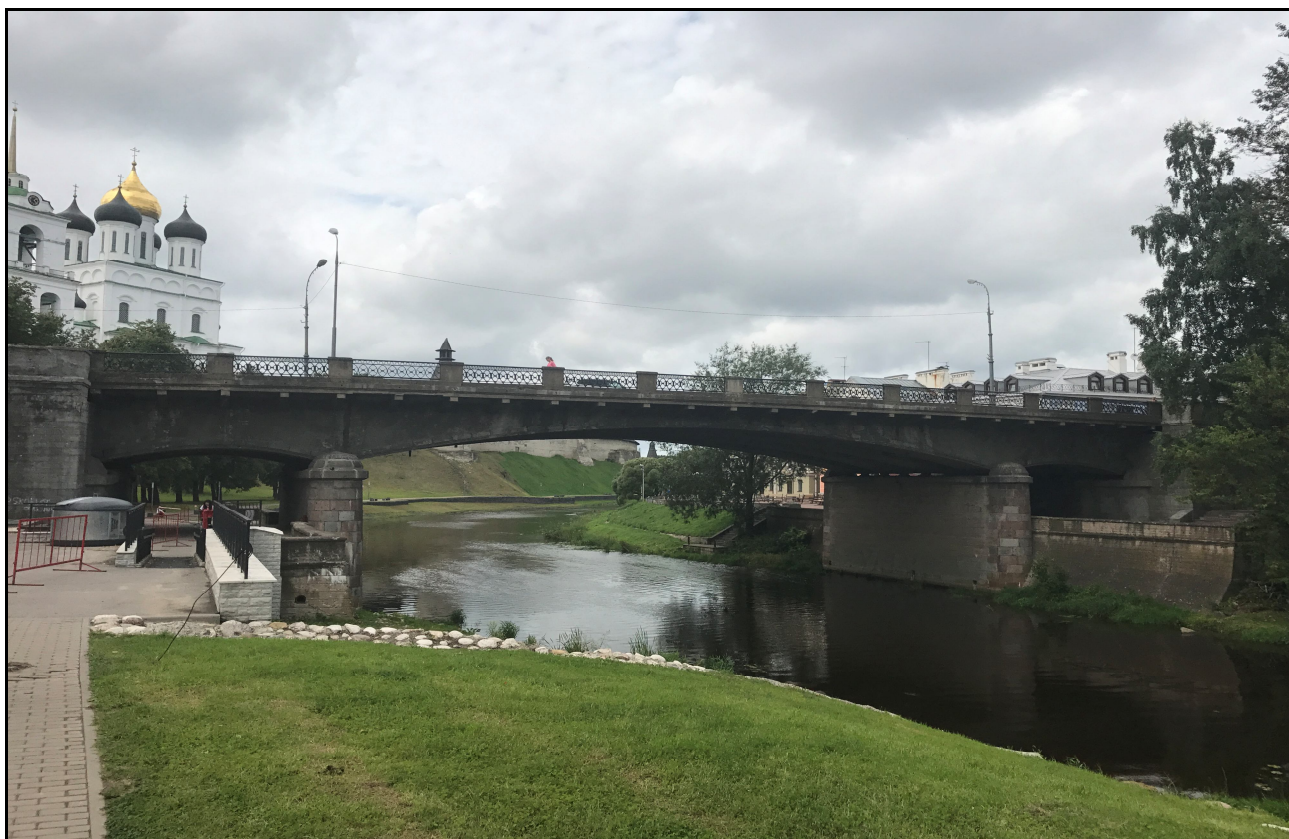
Рис.1. Общий вид моста (НМ, справа)
