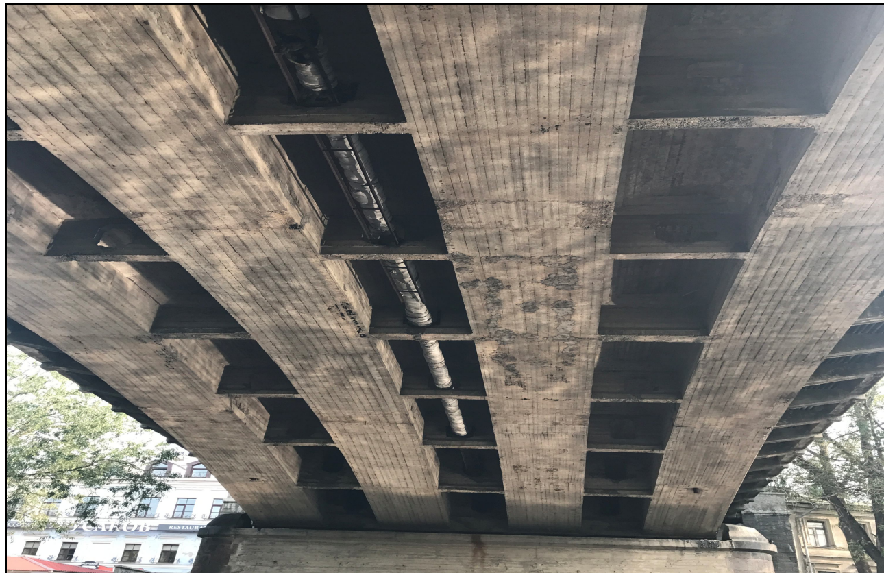
Рис. 6. Общий вид пролетного строения (от опоры 1)
