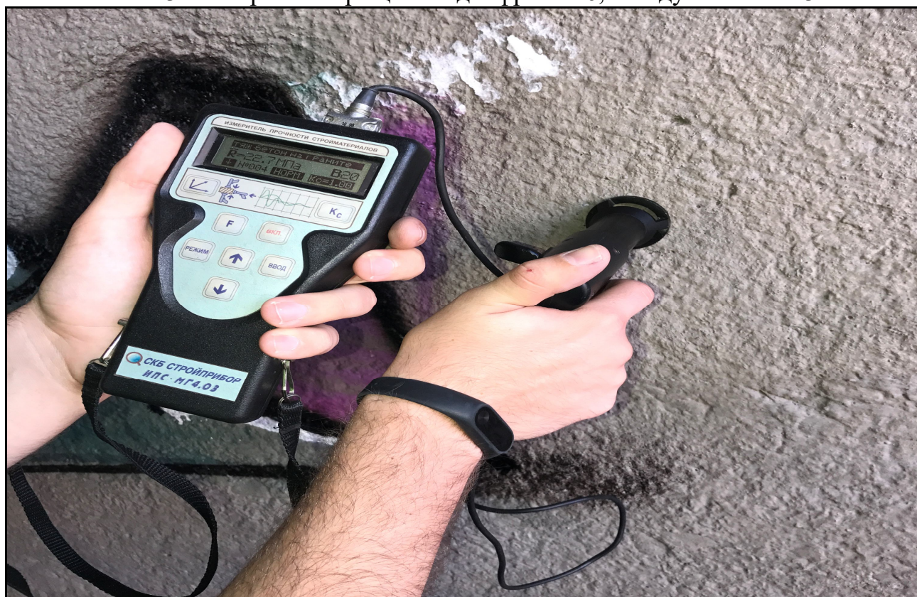
Рис.24. Измерение прочности бетона.
