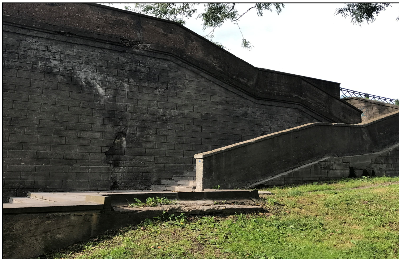
Рис. 7. Общий вид лестничного схода (подход 2, справа)
