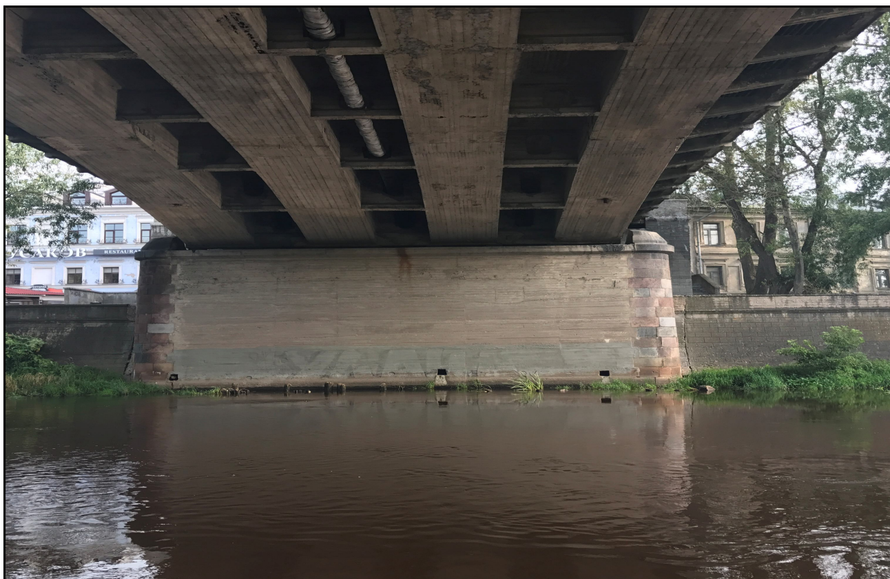
Рис.5. Общий вид опоры 2 (НМ)
