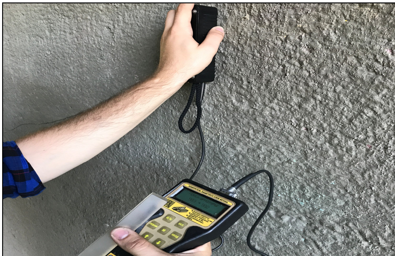
Рис.25. Измерение толщины защитного слоя.
