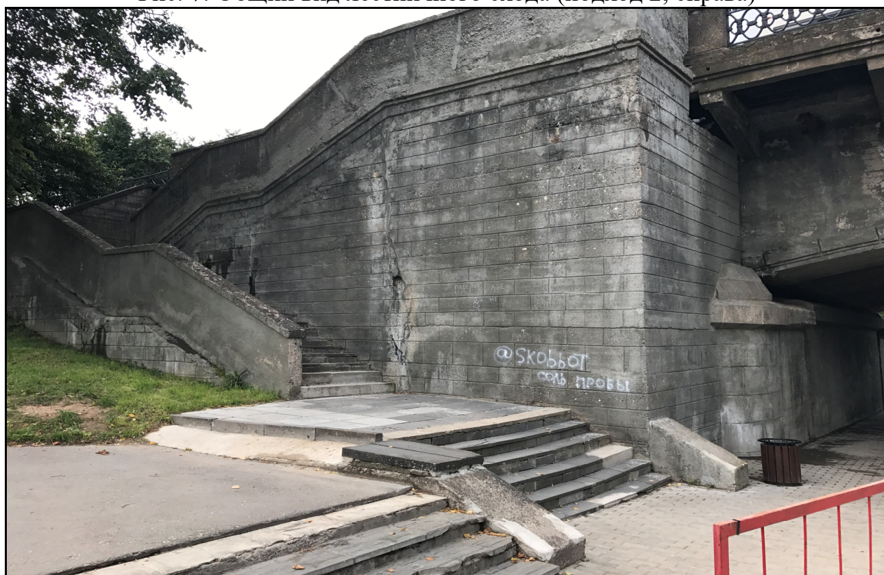
Рис.8. Общий вид лестничного схода ( подход 1, справа)
